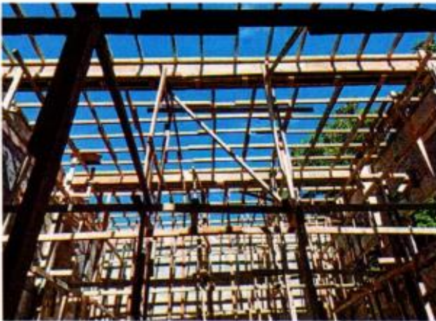
LOSA MULTIUSOS (ENCOFRADO)
