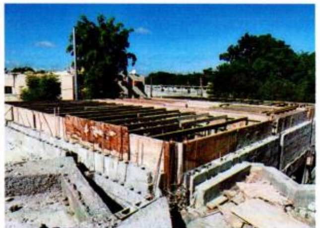
LOSA MULTIUSOS (ENCOFRADO)
