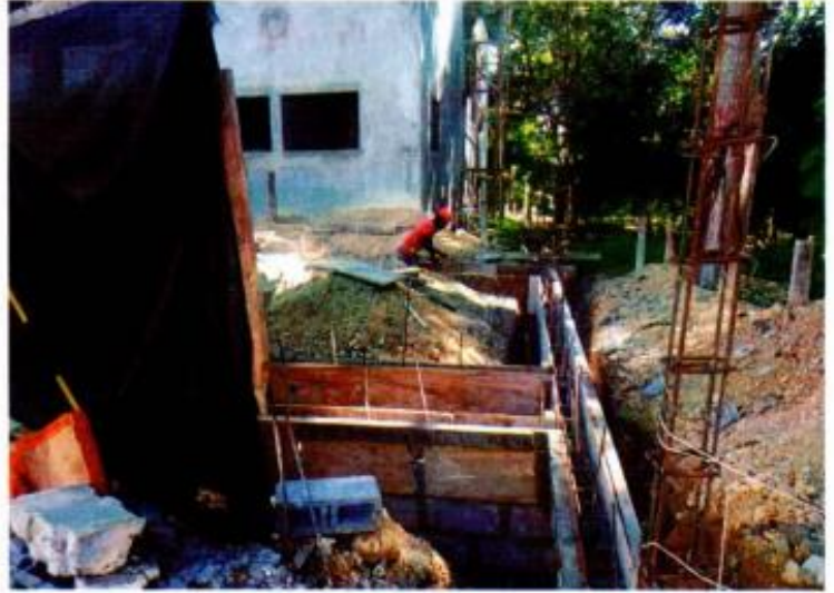
LOSA MULTIUSOS (ENCOFRADO)
